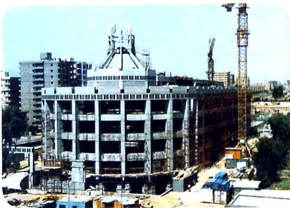
مبنى إنبى تحت الإنشاء
