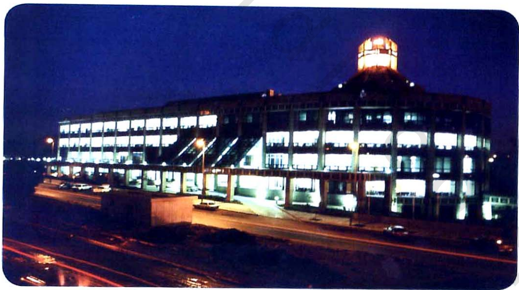
صورة ليلية للمبنى
